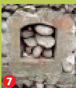
7 Orifice de puisage Deux sont encore visibles.
