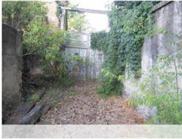
Photo 4. Vue sur l'accès à la parcelle BL 52
