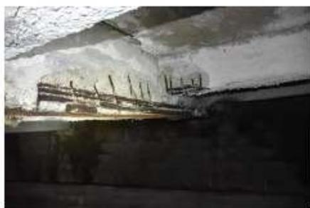
Lors d'une ancienne intervention, une couche de béton a été projetée sur le béton existant, mais cette couche se désagrège et ne protège plus ni aciers ni béton.
