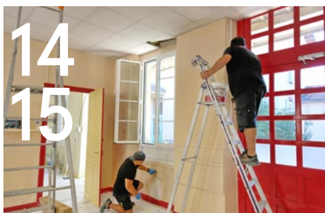
Travaux d'été dans les écoles
