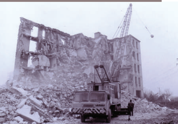
Démolition de l'immeuble des Pins, au quartier de la Monnaie, Romans, 1986. Photo Philippe Petiot
