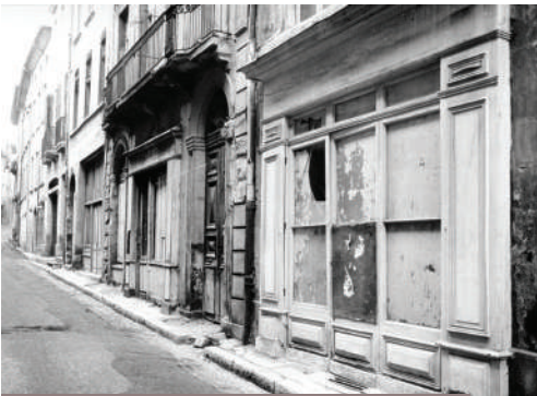
Réhabilitation du centre ancien, rue Pêcherie, Romans, 1981-2000
