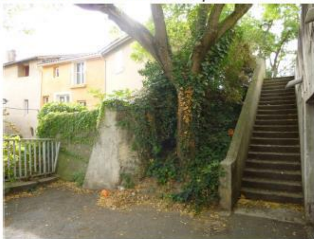
MUR EXISTANT ENTRE RUE BAUDOIN / EPAULE
